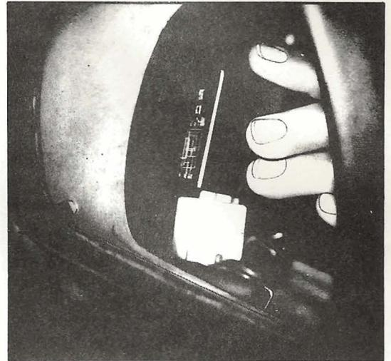
Coloque o novo automático. Por ter 3 pólos assimétricos o automático só encaixa na posição correta.
